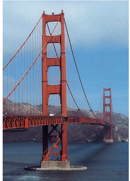
97.1. A Golden Gate híd. A vasbeton függőhidat két 227 m magas acéltorony tartja. A 90 cm vastag tartókötelek speciális nikkel-króm-acél ötvözetből készültek
